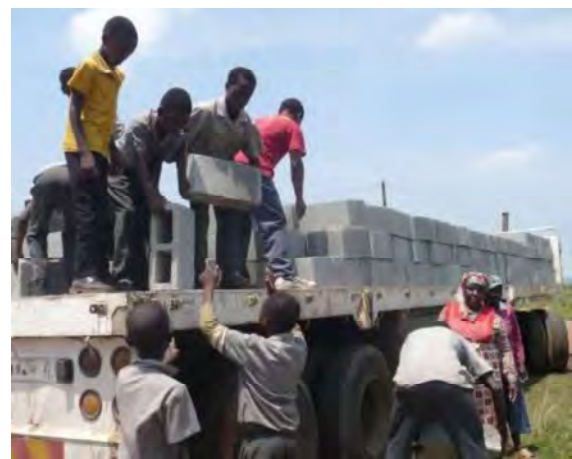
Die Steine für das Ausbildungszentrum werden abgeladen
